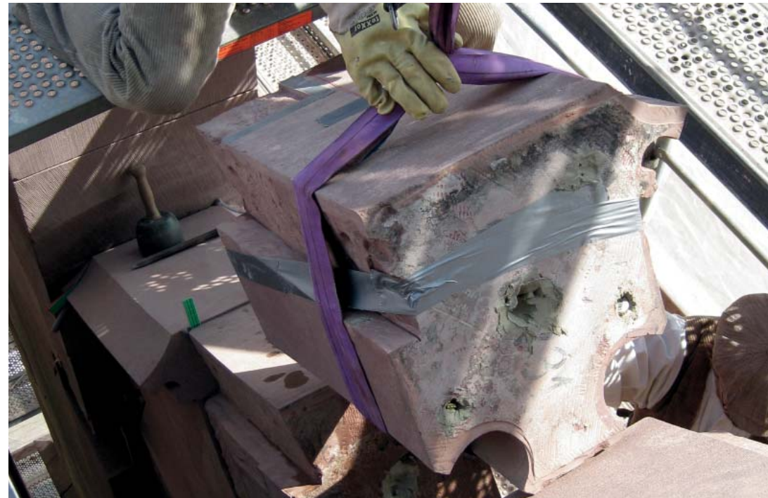
Reparatur durch Austausch
